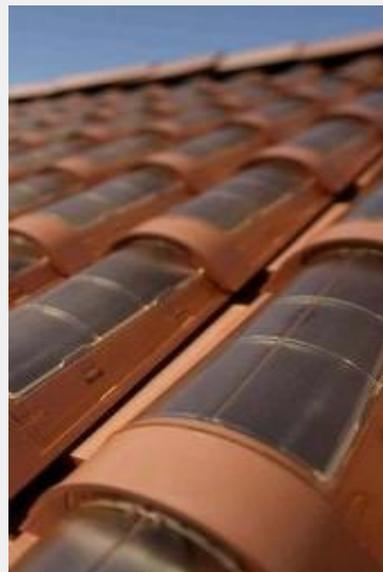
Da un punto di vista teorico, l'utilizzo del **coppo fotovoltaico** rende possibile una produzione superiore a **622.000 kWh**. Considerando un consumo medio di **3000 kWh** per nucleo di **2.5 persone**, il consumo medio della popolazione di nuovo insediamento (**520 unità**) sarebbe di **624.000 kWh**. La produzione di energia mediante coppi fotovoltaici sarebbe quindi in grado di coprire pressoché **l'intero fabbisogno del consumo della nuova popolazione del quartiere**.
