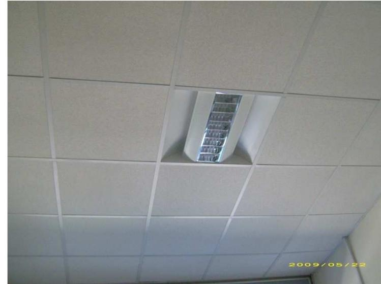
Nuovi controsoffitti in fibra minerale con apparecchi illuminanti a luce diretta/indiretta comandati da rilevatori di presenza
