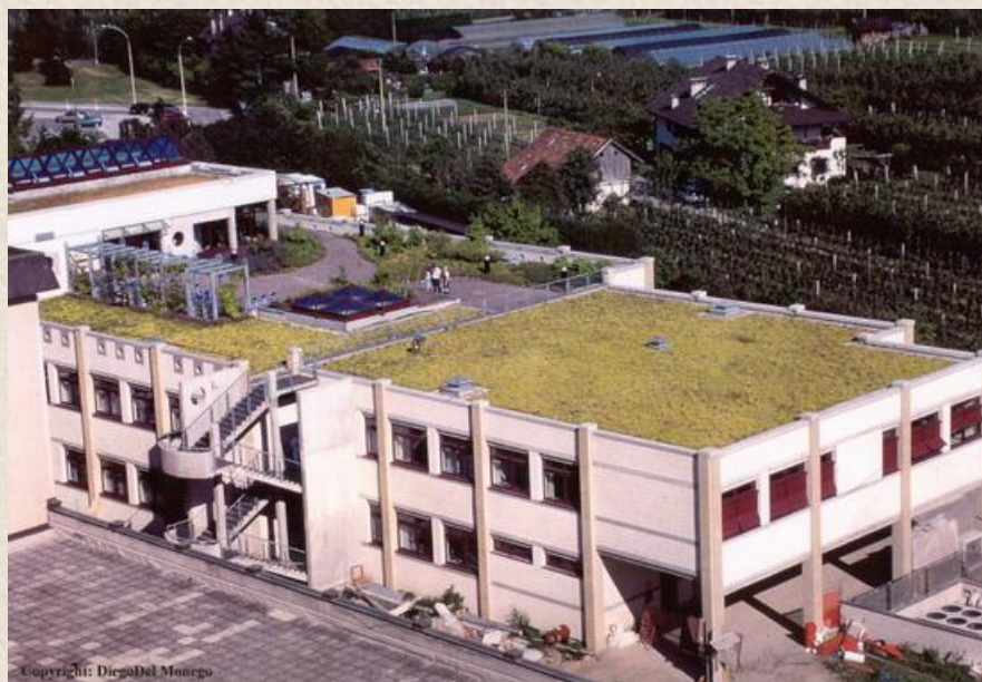
Coperture a verde dell'ampliamento dell'Ospedale generale provinciale di Bolzano
