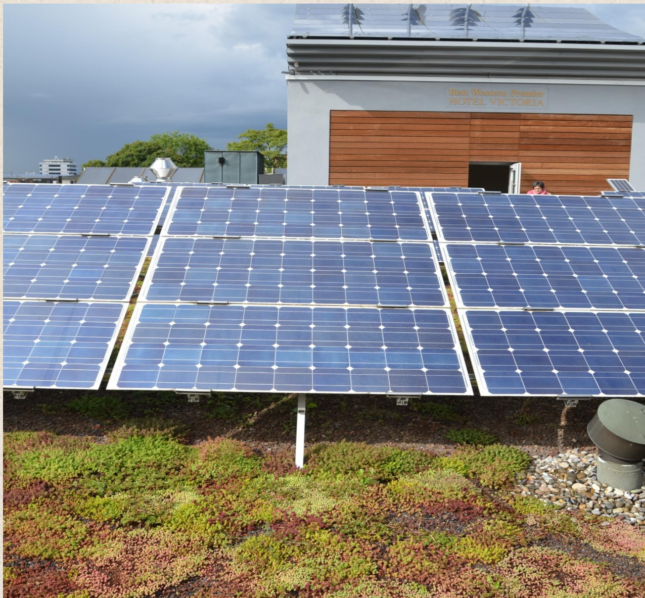
Hotel Vittoria, Friburgo (Germania). Copertura a verde di tipo intensivo calpestabile,
