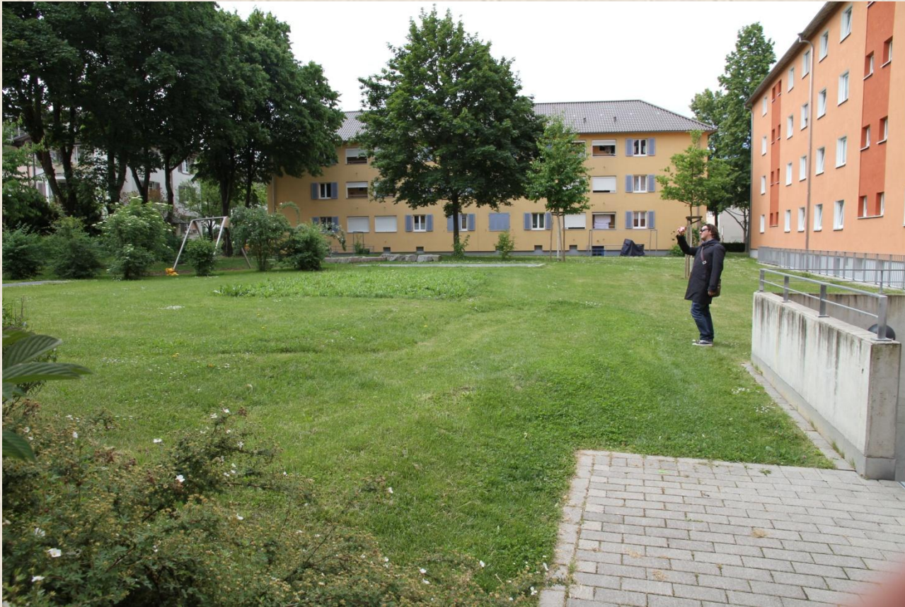
Ammodernamento di edifici degli anni 60 pianificato dall'istituto case popolari di Friburgo (Germania). Copertura a verde di tipo intensivo calpestabile, solaio autorimessa.
