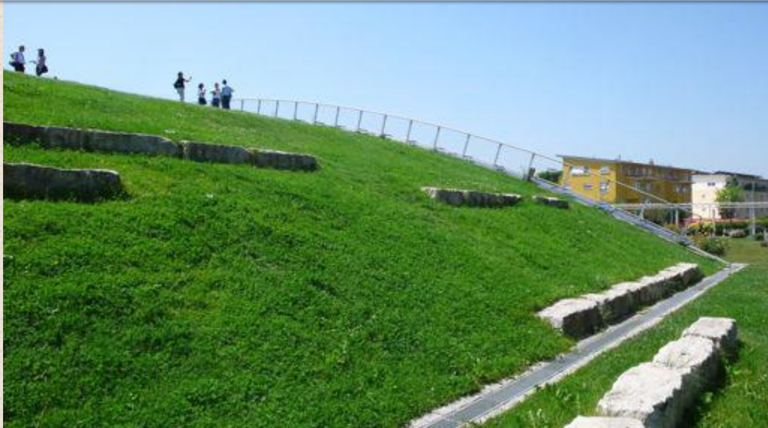
Sports hall Clara-Grunewald School, Friburgo (Germania). Copertura verde di tipo intensivo calpestabile
